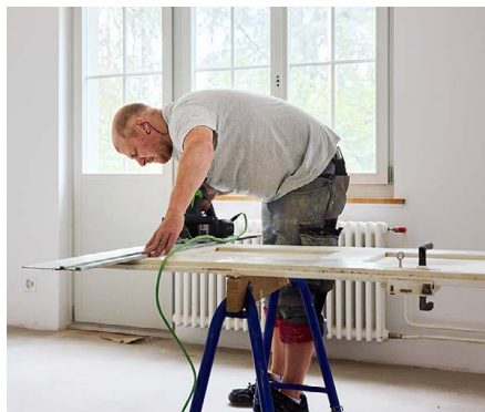
Die Sanierungsarbeiten starteten im Juli 2023.
